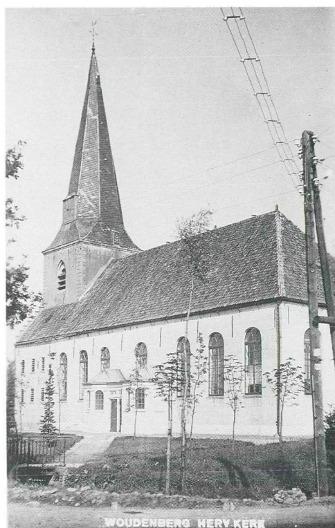
De zuidgevel van de Hervormde kerk voor de restauratie van 1952. De muren waren wit gepleisterd en de toren was ingebouwd. Aan deze zijde van de toren van het brandspuithuis. (Coll. H. Schouten).
