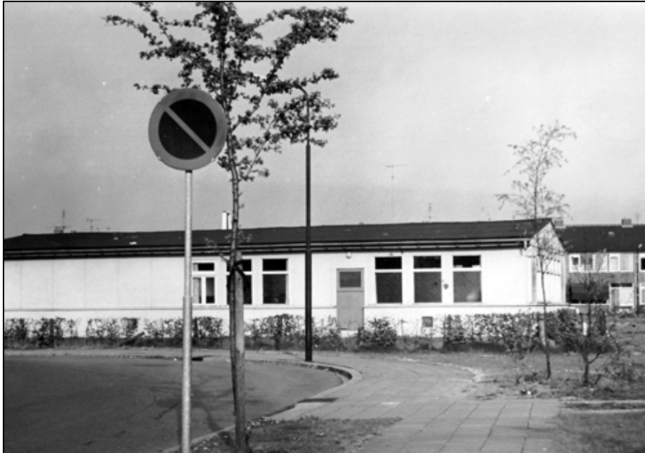
De tweede noodkapel van de rooms-katholieke Catharinaparochie in 1966. De vorige was in december 1965 door brand onherstelbaar beschadigd. Zij staat op de plek waar tegenwoordig de stenen kerk staat. Gezien van west naar oost. (foto OW32236)
